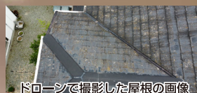
ドローンで撮影した屋根の画像
