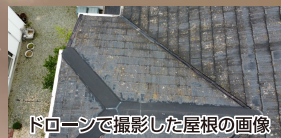
ドローンで撮影した屋根の画像
