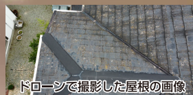
ドローンで撮影した屋根の画像
