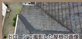
ドローンで撮影した屋根の画像
